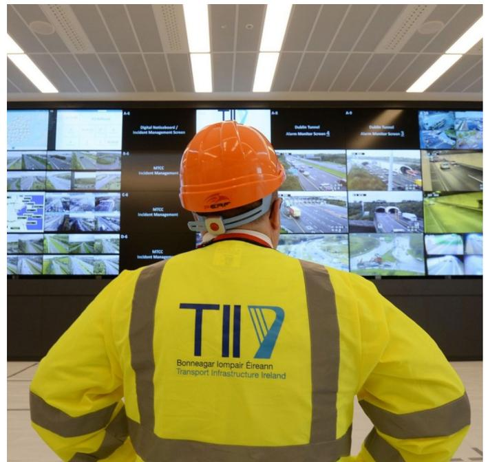
52 MultiSync® UN551S 55-Zoll-Displays mit ultraschmalen Rand werden als 13 x 4 Videowand installiert, wobei der kleinste Bildzwischenraum lediglich 1,8 mm beträgt.
